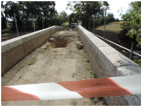
Des travaux nécessaires
