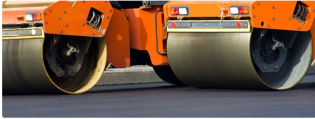
Commune de Lectoure : Travaux sur la RN21
