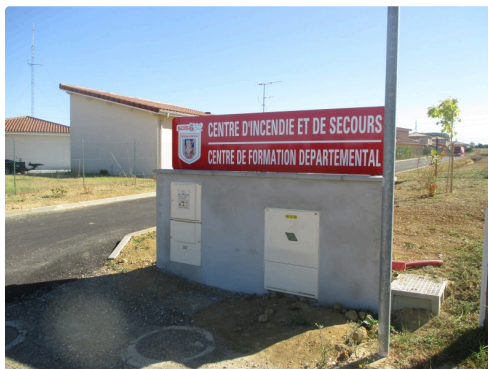
Entrée du nouveau centre de secours
