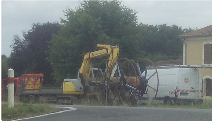
10M€ de travaux prévus par le Syndicat d'électrification
