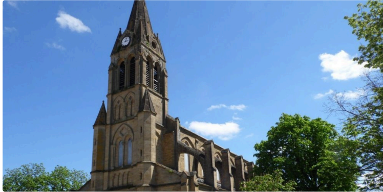
Travaux de réhabilitation de l' Eglise
