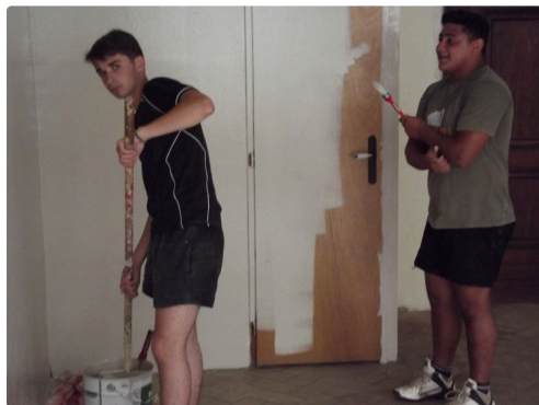
Travaux de peinture
