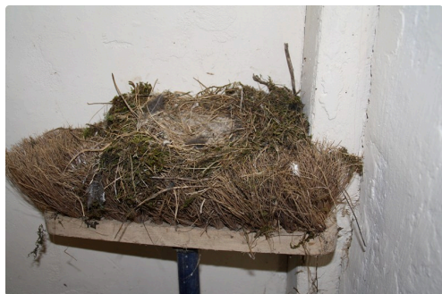
Chapelle de Goutz un logement abandonné
