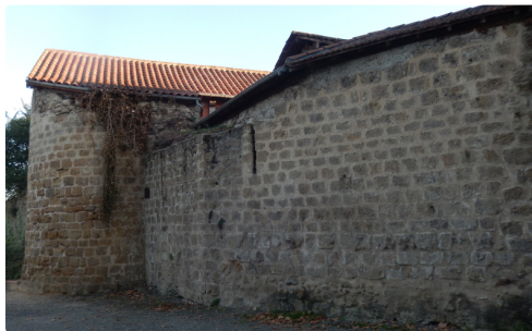
Murs d'enceinte et de protection
