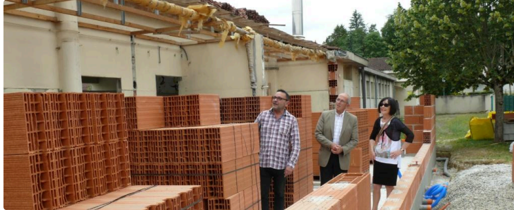
Pavie : Des travaux conséquents ont débuté à l'école primaire
