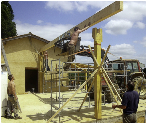
Le saloon en construction - Photo Carchet City
