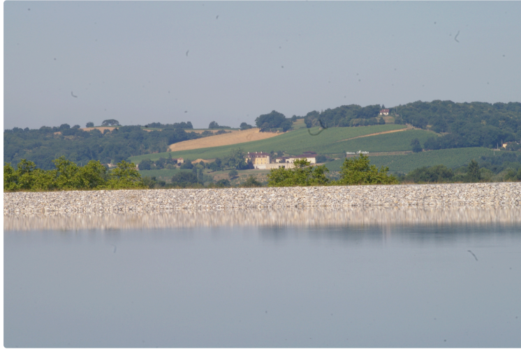
Le barrage de "La Barne" opérationnel
