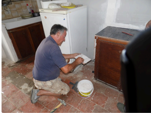
Carreleurs a l'ouvrage "Alphonse"
