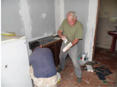
Carreleurs a l'ouvrage "Loulou"
