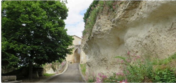
Attention, chute de pierres !
