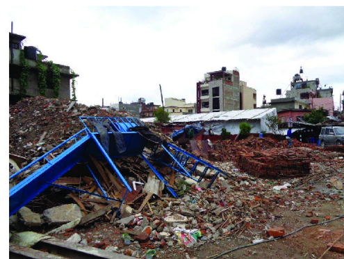
L'école Suryodaya après le séisme du 25 avril 2015.
