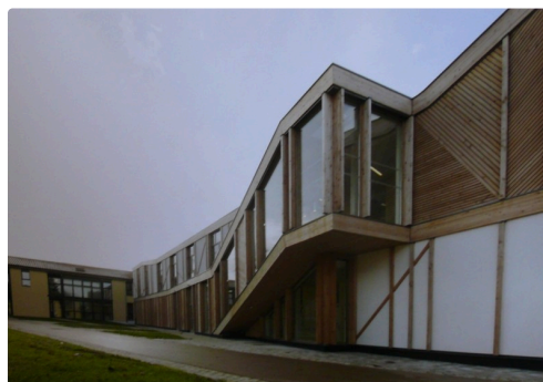
Façade nord de la cité de la transition énergétique.
