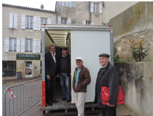
l'un des nouveaux blocs WC réalisés
