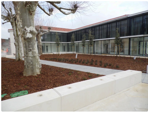
La dernière tranche et le jardin d'agrément sont terminés
