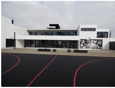
L'aire sportive donne sur les bâtiments de la première tranche
