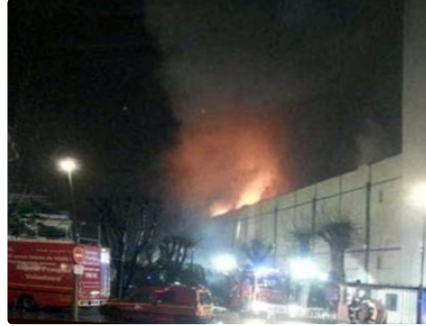
Pau 2000m 2 partent en fumée au centre ville
