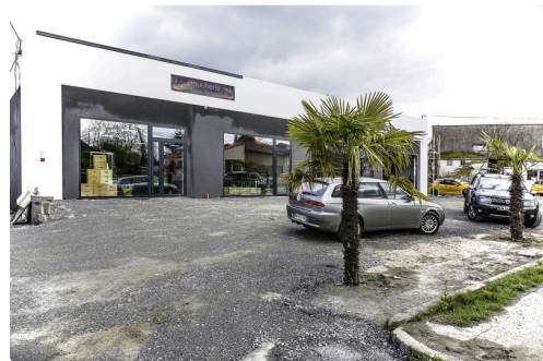
Façade du nouvel ensemble
