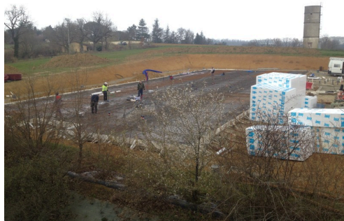
Vue des travaux.
