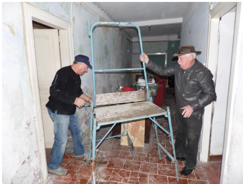
Mise en place d'une "Gazelle" petit échafaudage mobile
