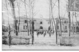
Les ultimes travaux au collège Pasteur
