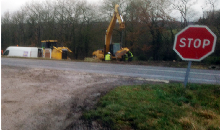
Sécurisation de la RN21
