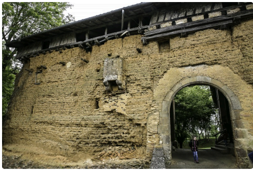
Le rempart en terre crue du Castet
