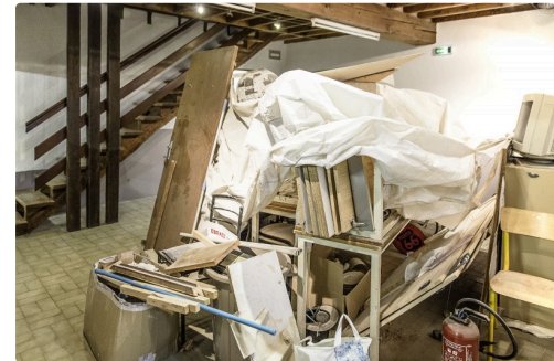
L'escalier n'a pas bougé
